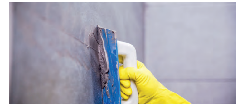
Use a grout trowel to affix the material | Utiliza una llana de rejuntado para fijar el material | Utiliser une spatule pour joints pour fixer le joint | Verwenden Sie eine Fugenkelle zum Andrücken des Materials
