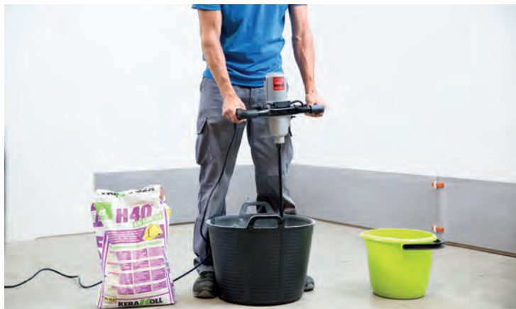
Prepare the adhesive cement | Prepara el cemento de agarre | Préparer le ciment à prise rapide Bereiten Sie den Klebemörtel vor
