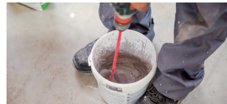
Prepare the grout | Prepara el material de rejuntado | Préparer le matériel de joint | Rühren Sie das Fugematerial an
